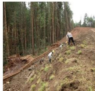
Fotografía 12. Revegetalización de taludes
