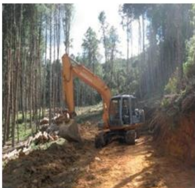
Fotografía 10. Construcción de vías forestales
