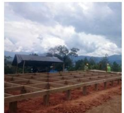
Fotografía 6. Construcción campamento Yolombó
