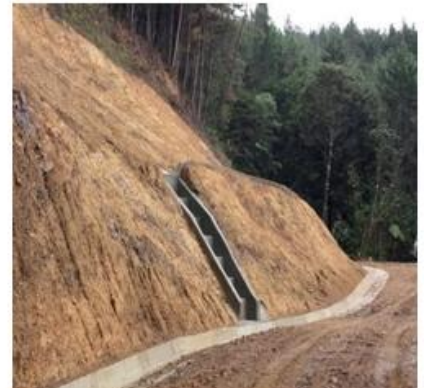
Fotografía 9. Obras control erosión
