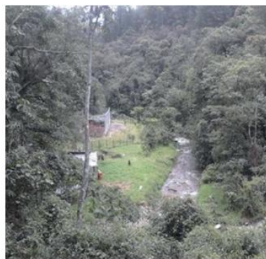
Fotografía 15. Bocatoma acueducto veredal Núcleo Yarumal
