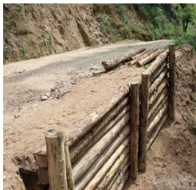
Fotografía 11. Construcción de Trinchos
